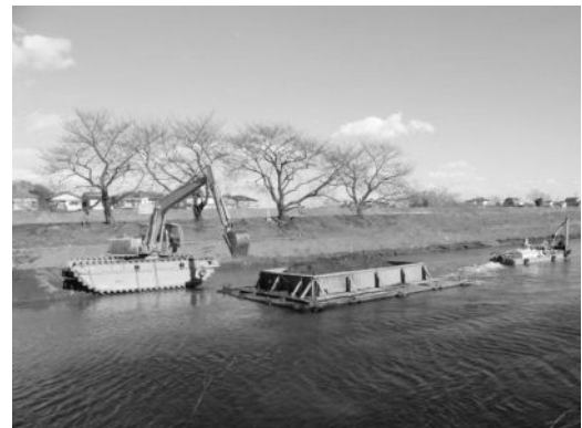
新河岸川治水対策の浚渫工事(05. 2. 3)
