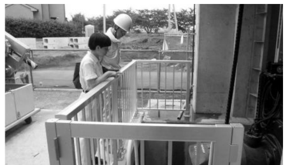
館第2排水ポンプ場工事現場を視察(05. 07. 19)
