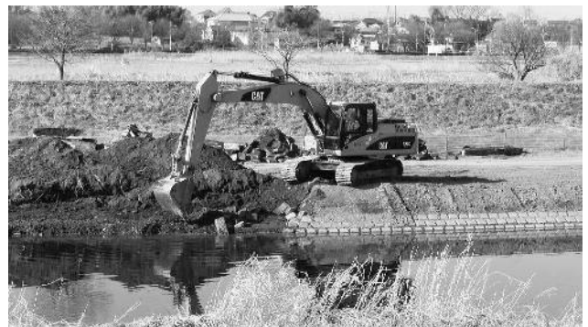
柳瀬川での浚渫工事(2012. 2. 21)
