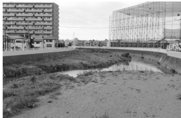
柳瀬川に堆積している土砂 (2019.11.19)
